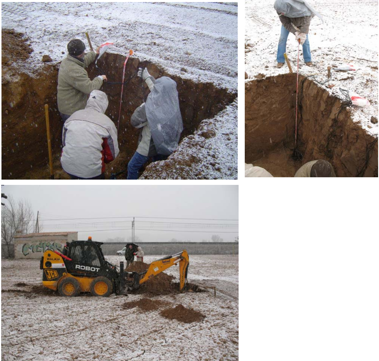
Figura 2. Proceso de instalación de los sensores de humedad y temperatura
